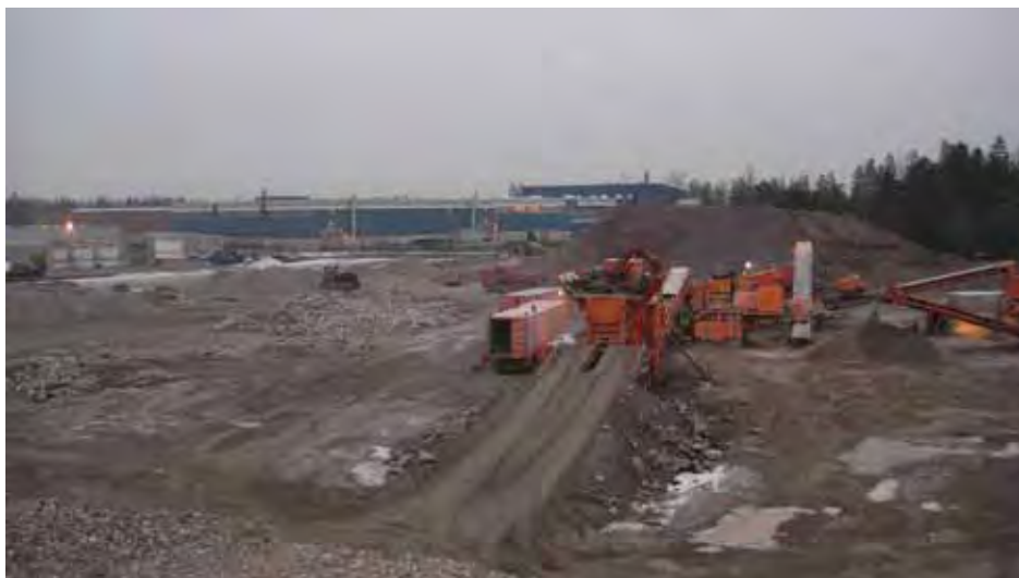
Kuva 4. Alueella murskataan ylijäämälouhetta (kuva 15.12.2008)
